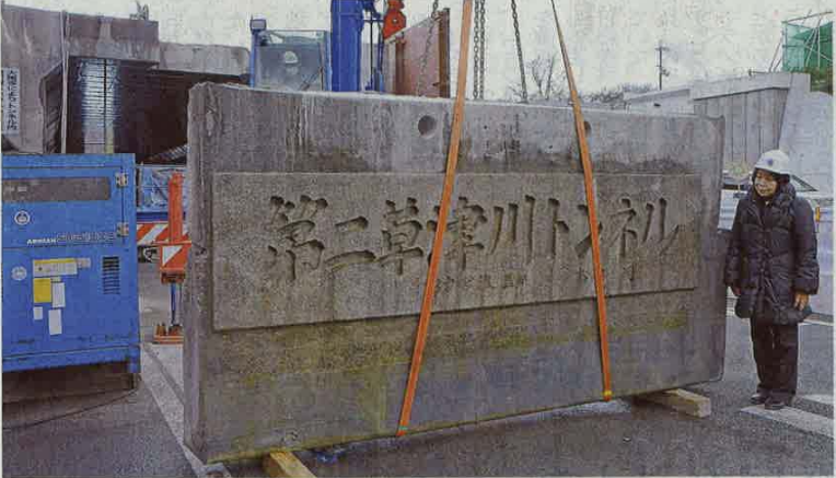
取り外された草津川トンネルの銘板を見つめる岸本さん。後方ではトンネルの撤去工事が進む(草津市大路3丁目)
